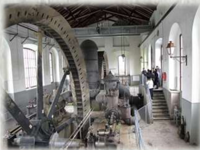
Photo : L'usine élévatoire - © OT du Pays de l'Ourcq
