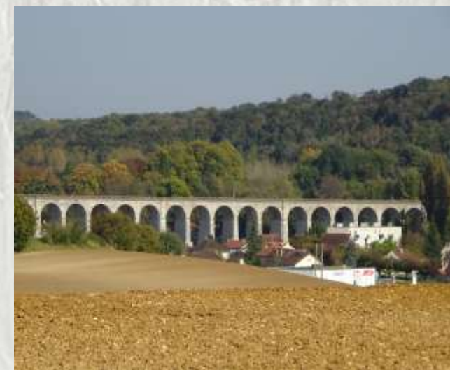
Viaduc de Longueville – Photo CD ©
