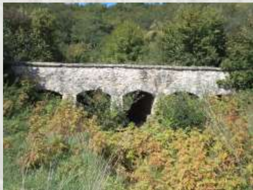
Le pont Vallerand – Photo RB ®
