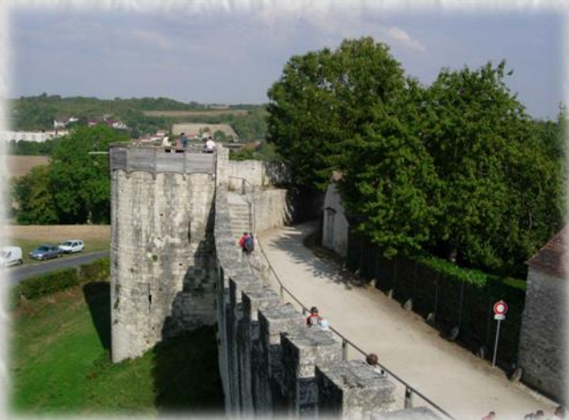
Photo : Les remparts de Provins - O.T ©
