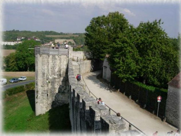
Photo : Les remparts de Provins - O.T ©
